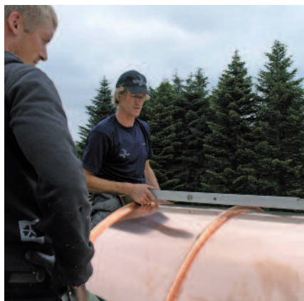
Der er mange detaljer og en del blikkenslagerarbejde i at lægge en kobbermønning.
