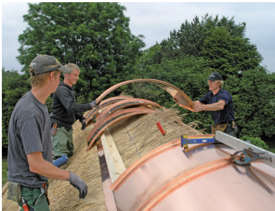
Efter nogle timers forberedelse går det stærkt, når tre tækkemænd samarbejder om at lægge kobber på toppen – til højre Kim Andersen, forrest til venstre Kristoffer Ernst Andersen og bag ham Allan Hansen.
