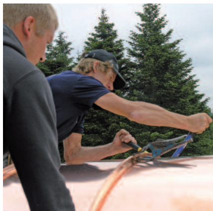
Der er mange detaljer og en del blikkenslagerarbejde i at lægge en kobbermønning.
