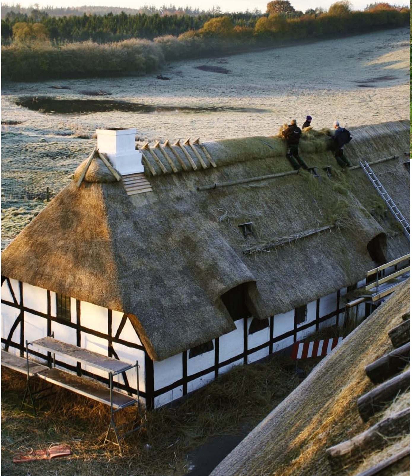
Et vinterbillede, hvor et smukt landskab og den smukke Tværskov Mølle ved Morud går i ét. Omkring 250 kvadratmeter er lagt, og rørene er syet på efter gammeldags opskrift
